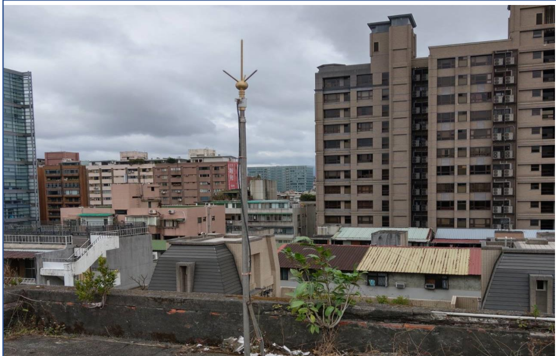
說明: PDCE 避雷針完成現況
